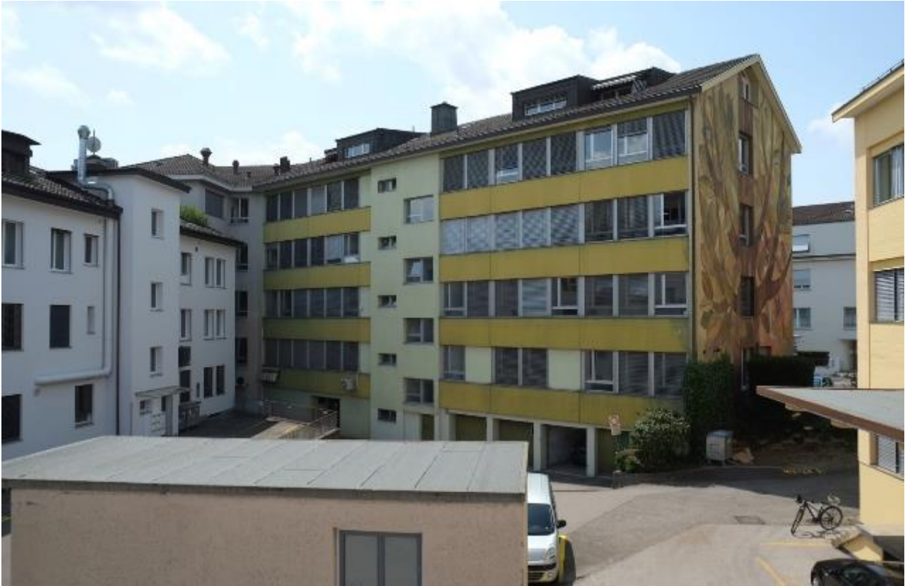
Abbildung 8: Die Ostfassade ist die Hoffassade
