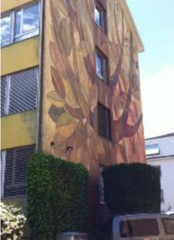
Abbildung 15: Giebelfassade heute mit Gemälde und aktueller Begrünung (Efeu)
